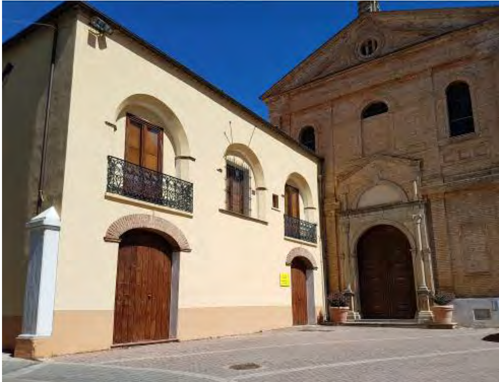
Figura 1. Ingressi del Palazzo Fortezza e della Chiesa di San Domenico in Acri (CS) [Foto: Carmine Lavorato - © - Archivio Gruppo Micologico Sila Greca - AMB]
